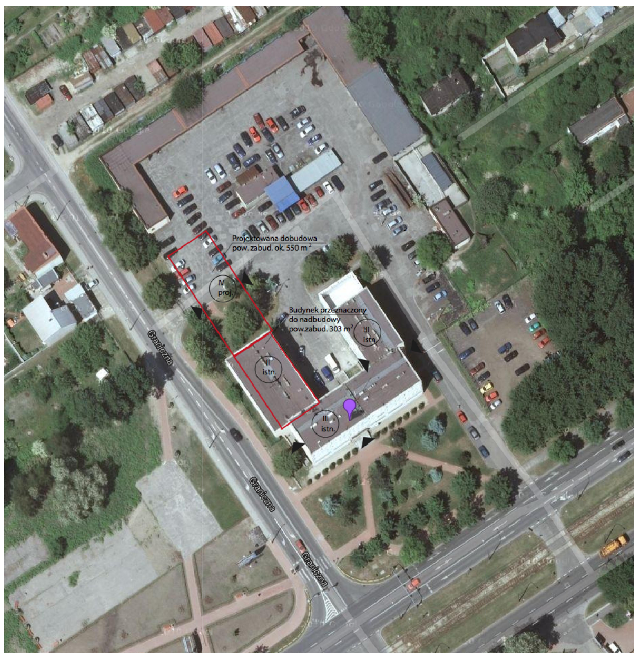
Fot.nr 1 Widok ogólny siedziby Komendy Policji w Dąbrowie Górniczej przy ul. Piłsudskiego 11
