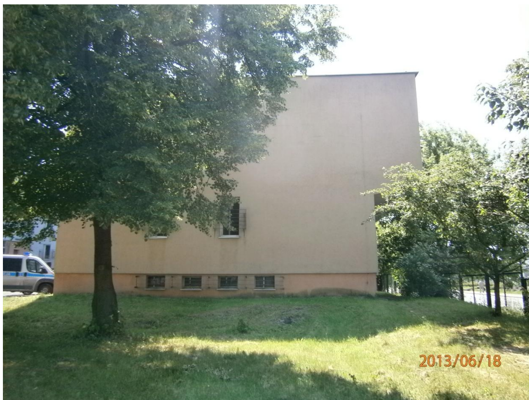
Fot. nr 2 - Elewacja północna budynku przeznaczonego do nadbudowy
